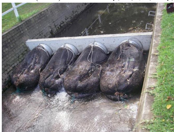
شکل 3- سیستم شبکه توری به دام انداختن زباله‌های پلاستیکی در جریان آب
